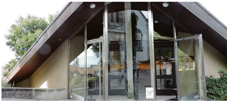
Désormais le centre paroissial mérite le détour aussi pour ses fascinants reflets. © Paroisse
